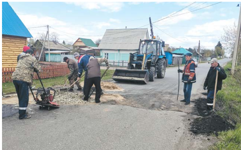
Работники МБУ «Городское хозяйство» проводят ремонт дорожного полотна на ул. Гвардейской (2024 г.).
