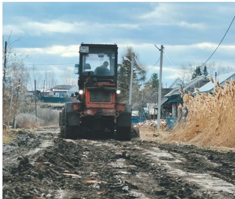
Идет грейдирование улицы Зеленой.
