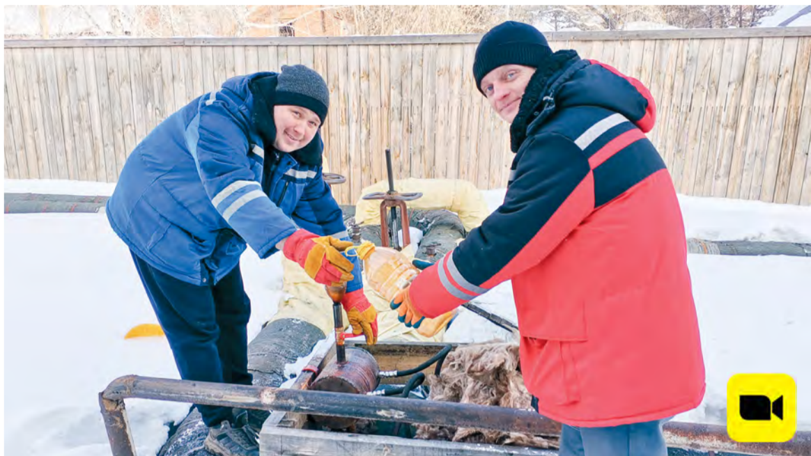
Мастер по теплосетям Валентин Инталев и слесарь ремонтной бригады Вячеслав Заливин наполняют систему отопления реагентом, с помощью которого трубы защищаются от коррозии и очищаются от ржавчины.
