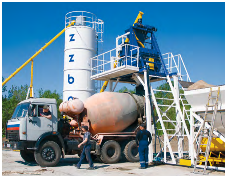
В Тарском речном порту ввели в эксплуатацию модульный бетонный завод производственной мощностью 30 кубометров в час.
