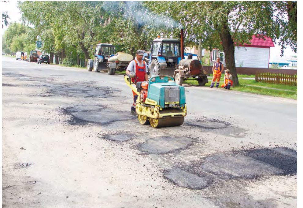
На прошлой неделе силами «Городского хозяйства» был отремонтирован участок дороги по улице Советской, от ул. Чкалова до ул. Гвардейской. К сожалению, ремонт не капитальный, средств хватило только на ямочный ремонт.
