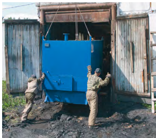
Монтаж котла в котельной адаптивной школы; инженер ПТО Иван Жигалов и главный инженер Евгений Курносенко запускают новое устройство.
